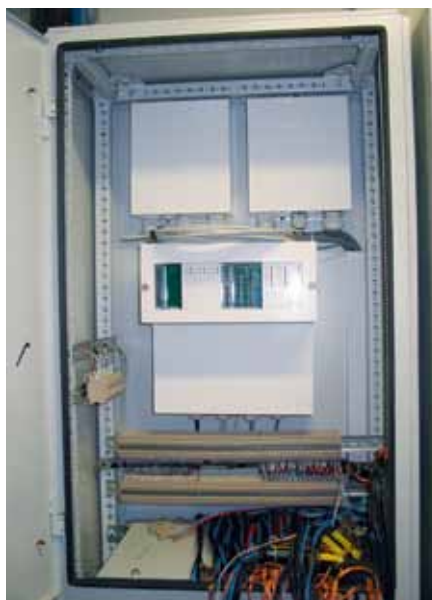
Рис. 1. ИУТК «Гранит-микро» (тип КПА-микро) на мобильной подстанции в процессе монтажа
