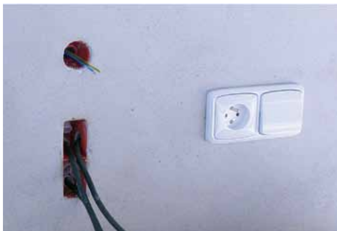
Рис. 3. Монтаж розеток и выключателей
