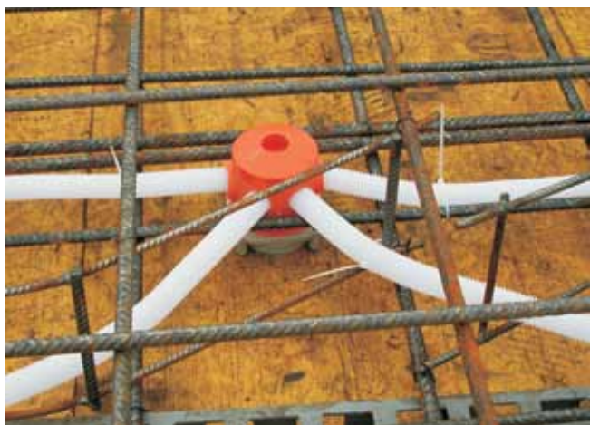
Рис. 2. Укомплектованная коробка, прикрепленная к опалубке
