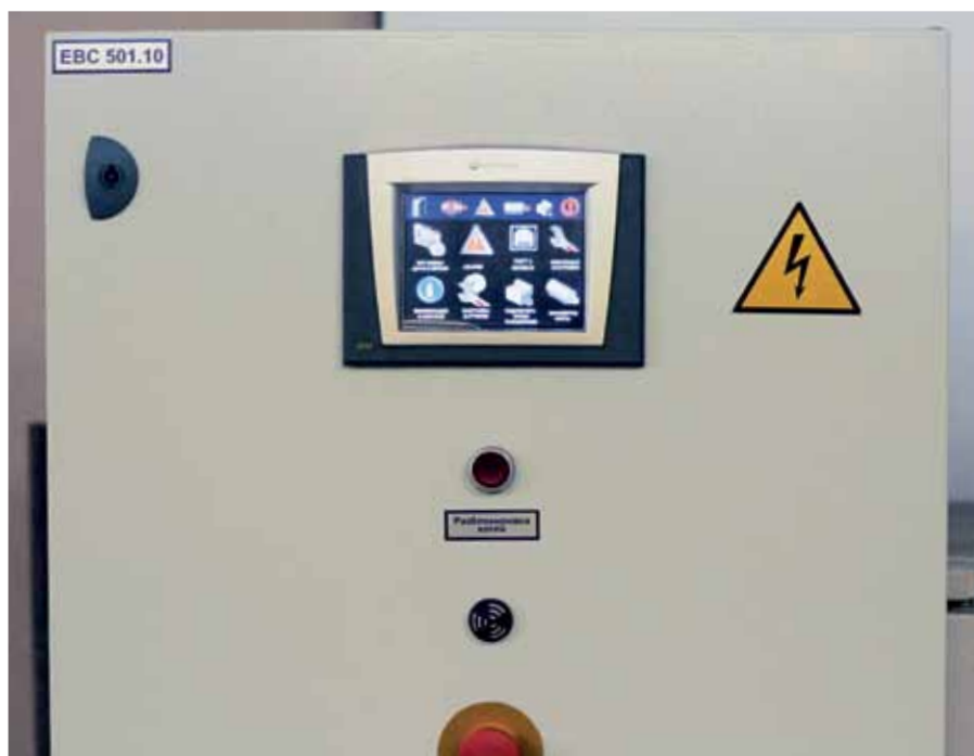
Рис. 3. Устройство автоматики для паровых котлов «ЭНТРОМАТИК EBC 501.10»
