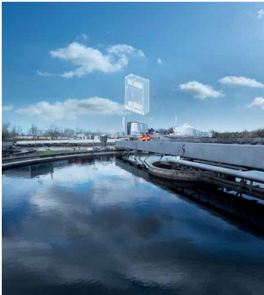
Рис. 1. Водоочистные сооружения служат для очистки воды от вредных примесей и доведения ее качества до показателей ГОСТ
