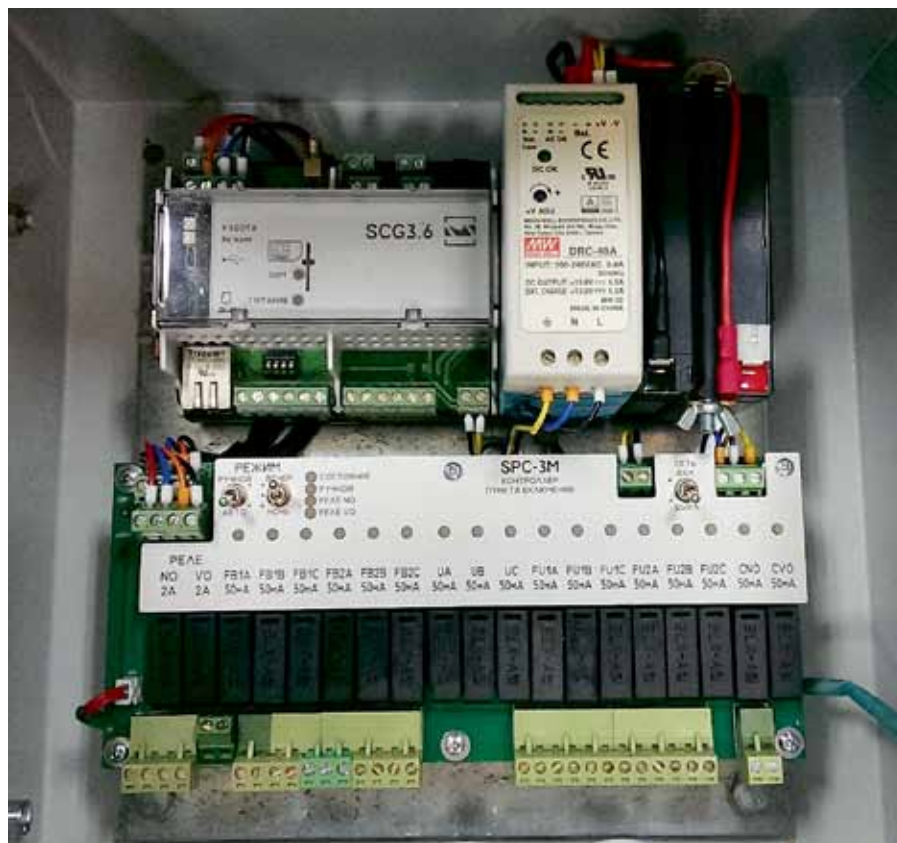
Рис. 1. Контроллер SPC-3M на пункте включения АСУНО
