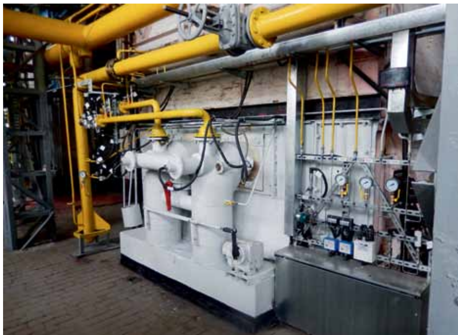
Рис. 1. Фронтальная часть котла ДКВР-10-13
