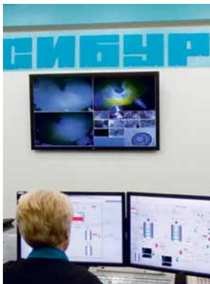
Рис. 4. В операторной установке «ТЭП-50»: на стене – видеoinформация из цеха; на мониторе оператора – мнемосхема рабочего процесса
