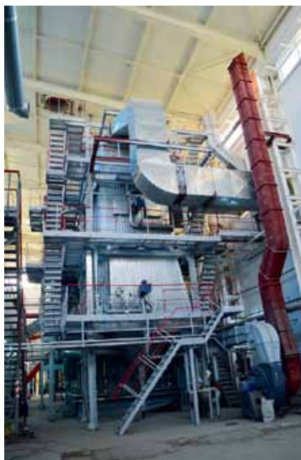
Рис. 1. Паровой котел Е-12-1,4Р в котельной предприятия
