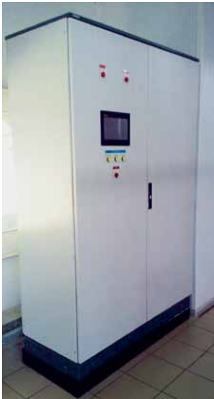
Рис. 4. Шкаф управления ШУ-Е-12 с панелью оператора
