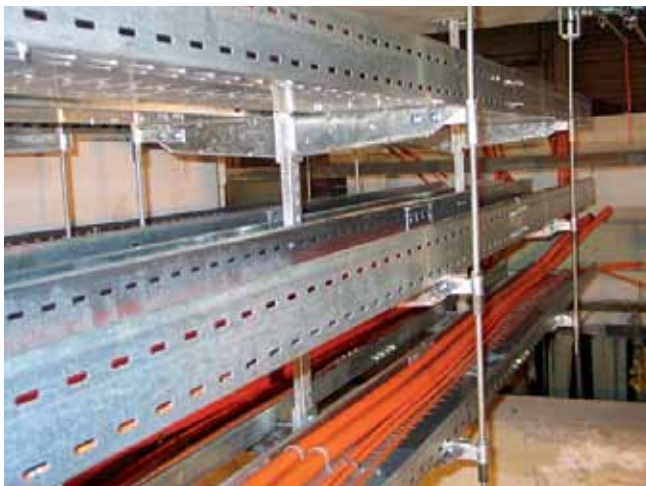
Рис. 3. Испытание лотков КОPOS и кабеля в лаборатории предприятия
