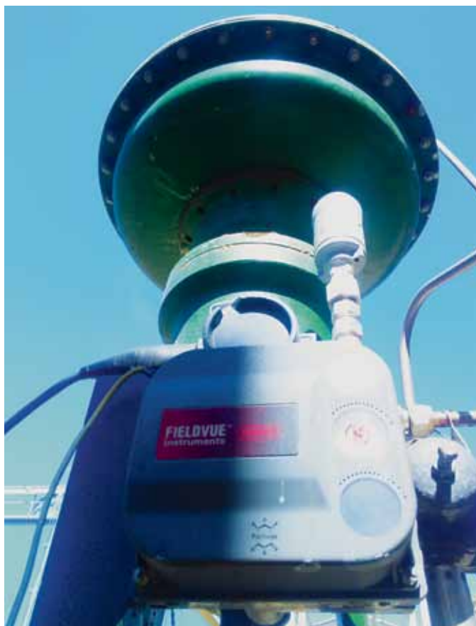
Рис. 2. Клапаны с интеллектуальными электропневматическими позиционерами FIELDVUE DVC
