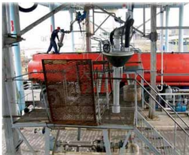
▲ Контроль уровня налива сырья: используется сигнализатор уровня модели «ТИТАН» серии 100
