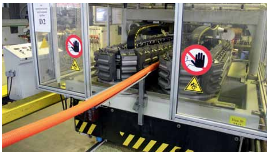
Рис. 2. Терминалы со считывателем и Wi-Fi-роутером в цехе, где производят гофрированную трубу на основе ПВХ, ПВД и ПВХ для электропроводки, а также двустенную трубу для канализации, электроэнергетики и дренажа
