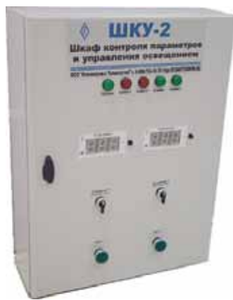
Рис. 2. Дисплей для отображения параметров, индикаторы и переключатели на двери ШКУ-2
