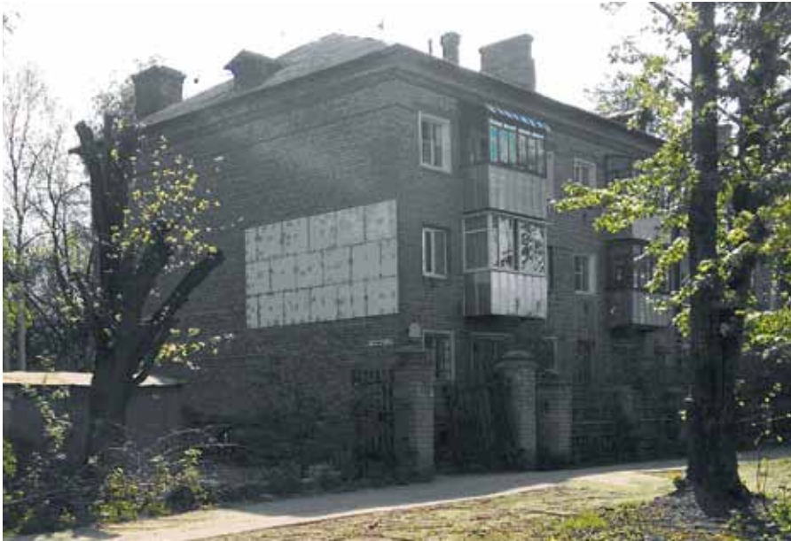
Рис. 2. Наружное утепление отдельной квартиры в многоквартирном доме
