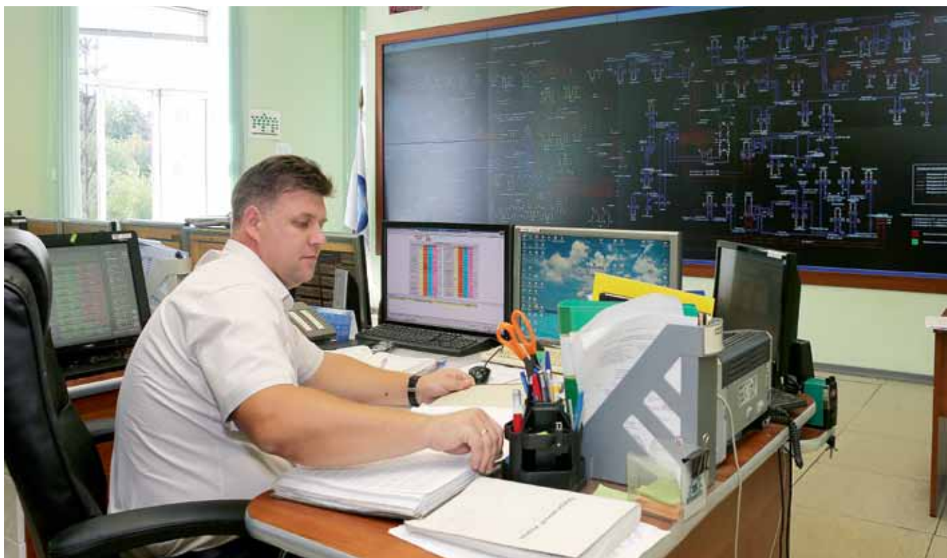
▲ Диспетчерский центр системы управления электрическими сетями «Ярэнерго»
