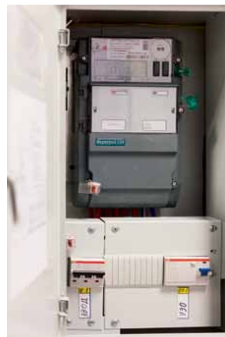
Рис. 7. Пломба роторного типа: слева – крупным планом, справа – установленная на счетчике
