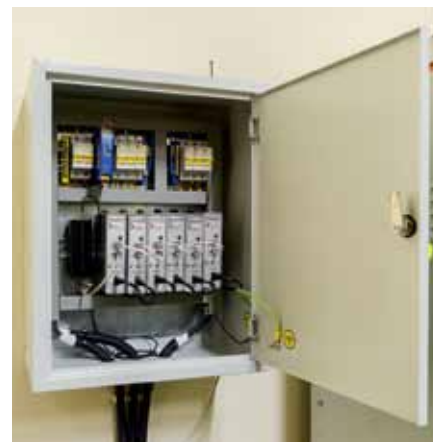
Рис. 6. Шкаф удаленного опроса с PLC-концентратором
