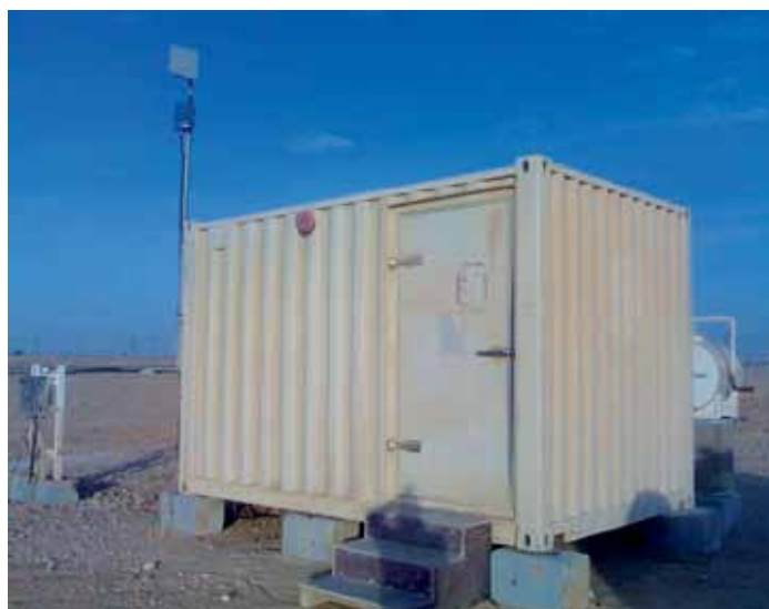
Рис. 4. Блок контроля со шлюзом SmartWireless на добывающем предприятии в Западной Сибири
