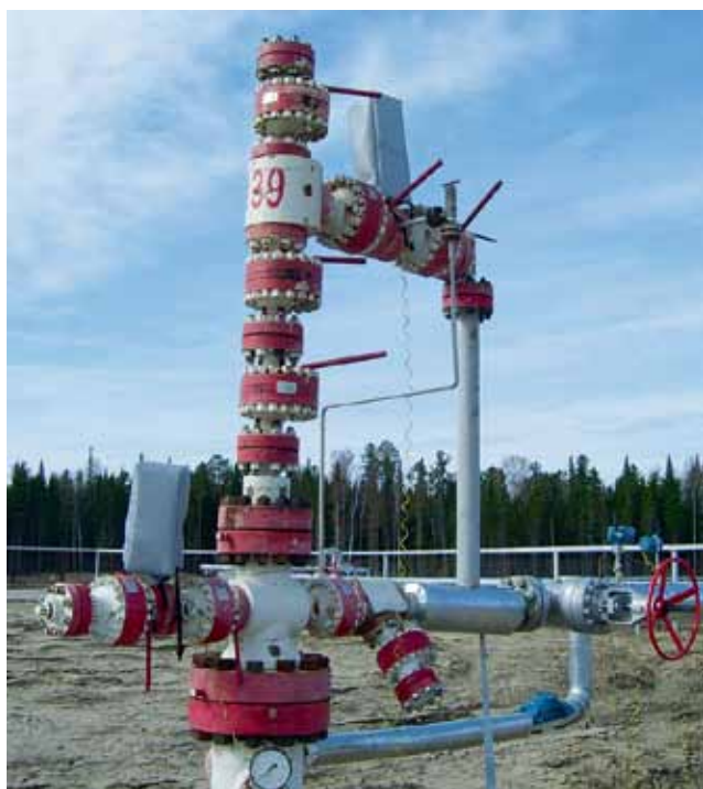
Рис. 3. Нефтедобыча в Западной Сибири: беспроводные датчики установлены на оборудовании устья скважины
