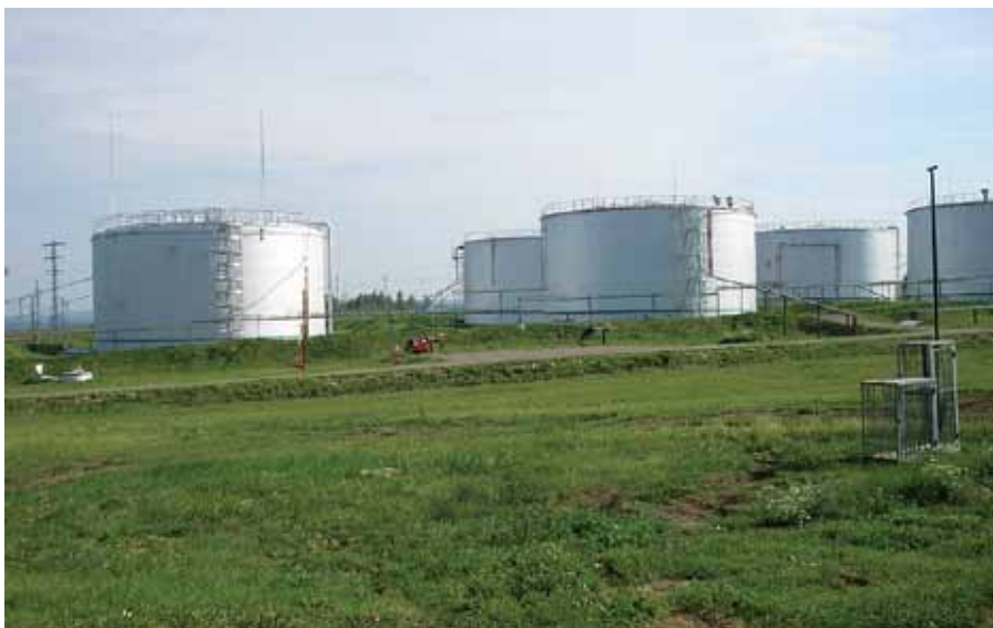
Рис. 5. Резервуары для хранения нефтепродуктов в Поволжье
