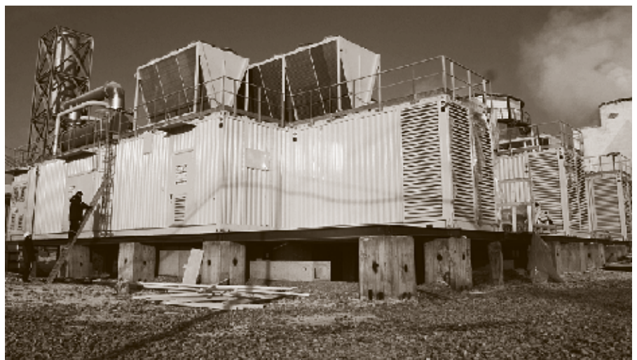
Рис. 1. ГПЭС на стадии монтажа
