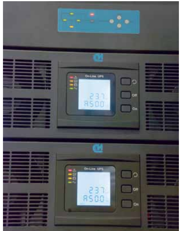
Рис. 2, 3. СИП380А МД: цифровой жидкокристаллический дисплей на силовых модулях повышает удобство эксплуатации
