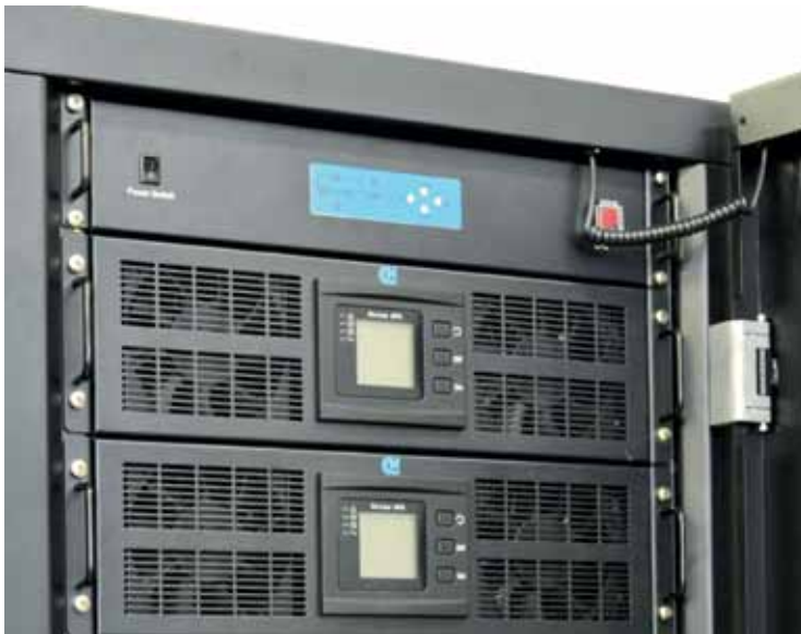
Рис. 2, 3. СИП380А МД: цифровой жидкокристаллический дисплей на силовых модулях повышает удобство эксплуатации
