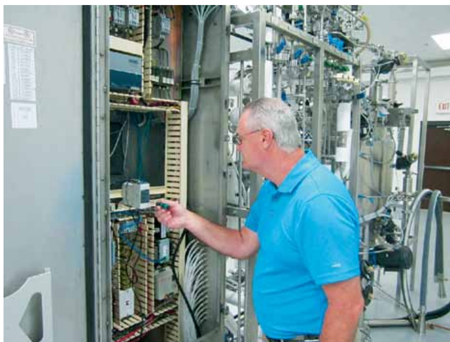
Рис. 4. Имитационный функциональный тест можно запустить, нажав кнопку на преобразователе Nivotester или на самом датчике
