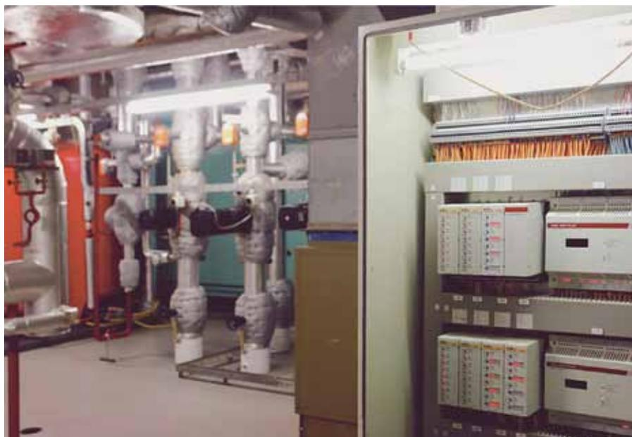
Рис. 5. Проект реконструкции АМЦ: «ветераны труда» – контроллеры Saia® PCD4 и PCD2 – исправно работают спустя 15 лет
