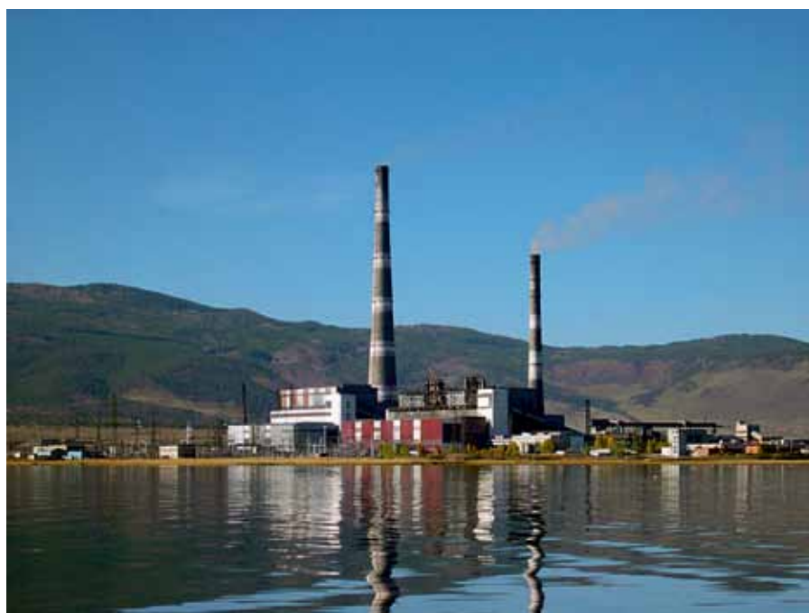
Рис. 1. ГРЭС на берегу Гусиноого озера в Загустайской долине (Республика Бурятия)
