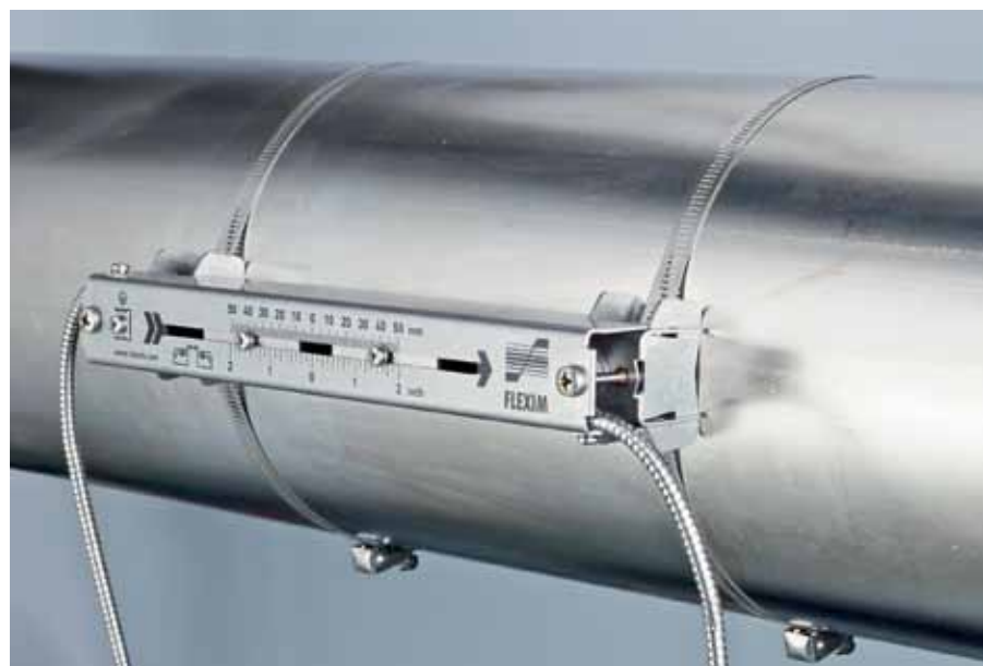
▲ Крепление датчиков на трубе
