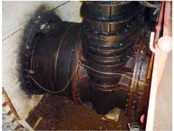
▲ Установки для учета расхода воды на трубопроводах больших диаметров: Назаровская ГРЭС (Красноярский край), ДУ = 1200...1800 мм
