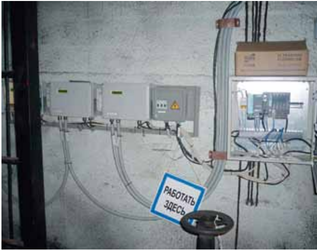
▲ Установки для учета расхода воды на трубопроводах больших диаметров: Назаровская ГРЭС (Красноярский край), ДУ = 1200...1800 мм
