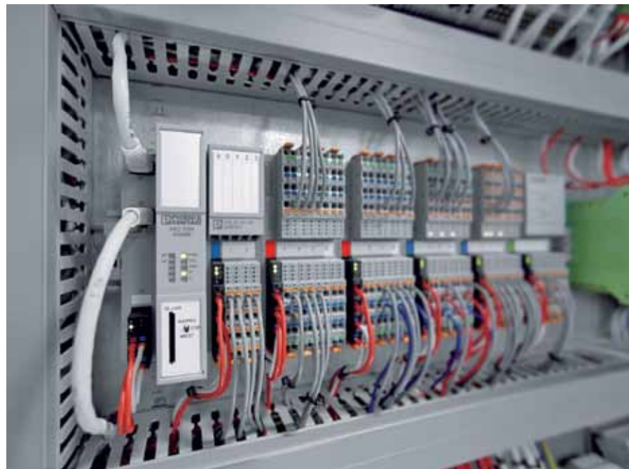
▲ Контроллер АХС с модулями, установленный в шкафу управления
