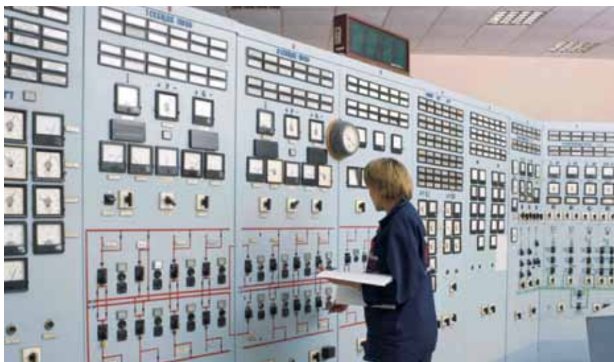
▲ Стрелочные приборы на щите управления в диспетчерской
