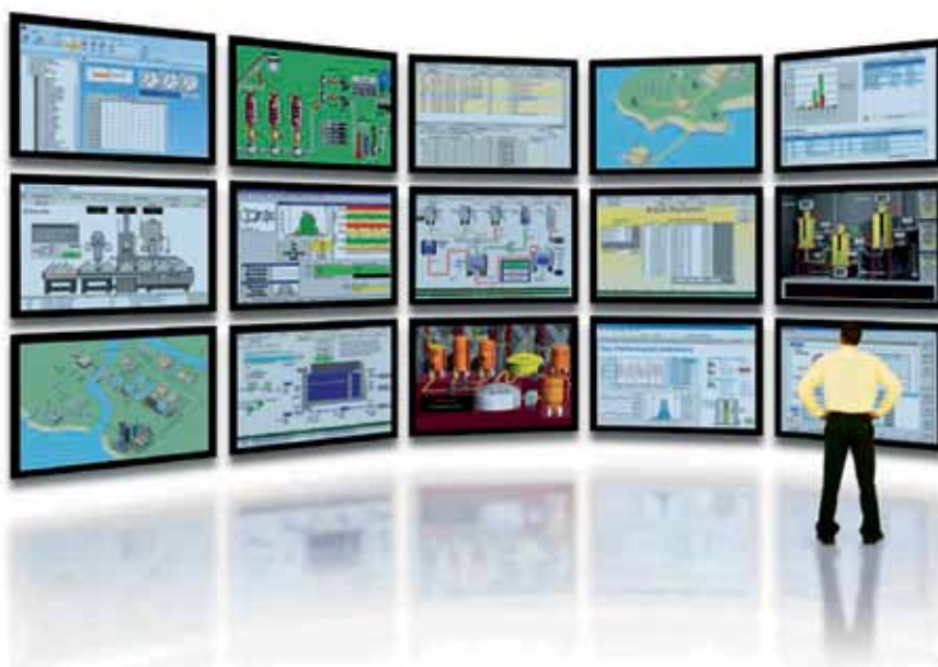
▲ SCADA-системы позволяют осуществлять полный контроль за всеми технологическими процессами
