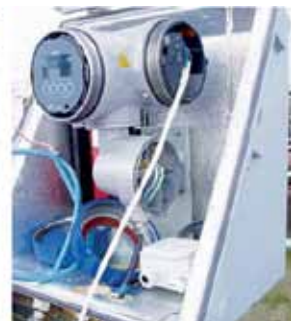
▲ OPTISONIC 6300F, средний. Трубопровод DN 150, PN 200. Добыча нефти – учет закачиваемых пластовых вод в скважину, компания «Тоталь», Республика Коми
