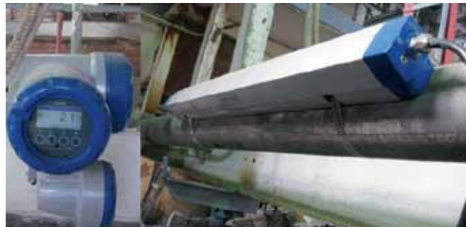
▲ OPTISONIC 6300F, средний. Трубопровод DN 100. Измерение расхода серной кислоты
