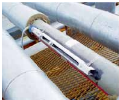
▲ OPTISONIC 6300F, средний. Трубопровод DN 150, PN 200. Добыча нефти – учет закачиваемых пластовых вод в скважину, компания «Тоталь», Республика Коми
