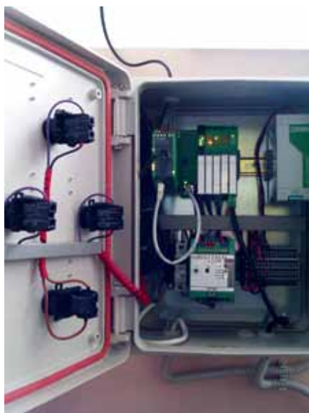
▲ Диктующая точка в системе дистанционного управления водоканалом: насосная станция и шкаф управления с контроллером
