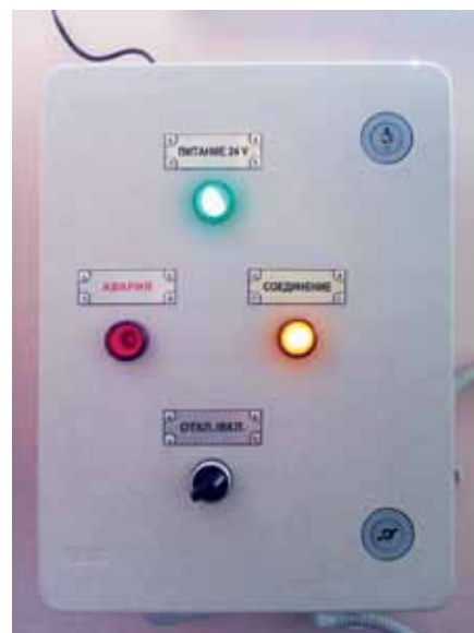
▲ Диктующая точка в системе дистанционного управления водоканалом: насосная станция и шкаф управления с контроллером
