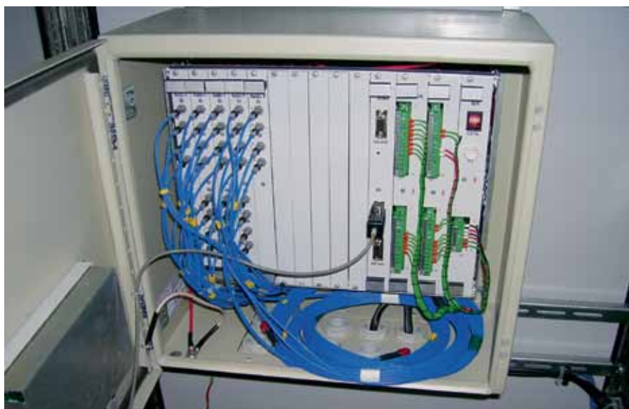
▲ Устройство дуговых защит «ОВОД-МД»
