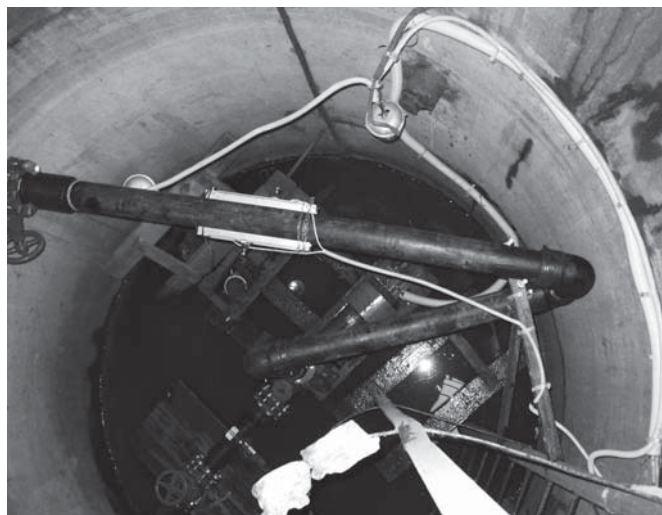
▲ Установка накладных датчиков ультразвукового расходомера
