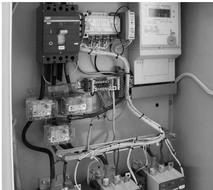
Рис. 6. Контроллер AnCom RM/L в составе пункта включения АСУНО на железнодорожной станции
