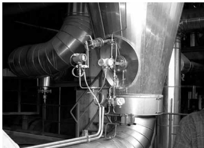
Рис. 2. Сенсор ERS высокого давления, установленный внизу резервуара
