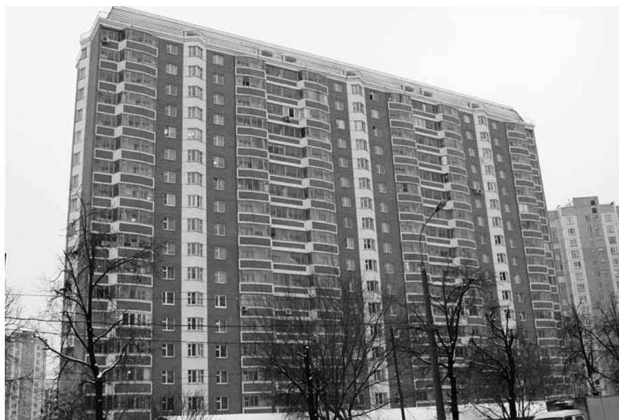
▲ Жилой дом по адресу: г. Москва, Лермонтовский проспект, д. 16. В доме впервые в России была реализована комплексная автоматизированная система поквартирного коммерческого учета воды, тепла и электроэнергии
