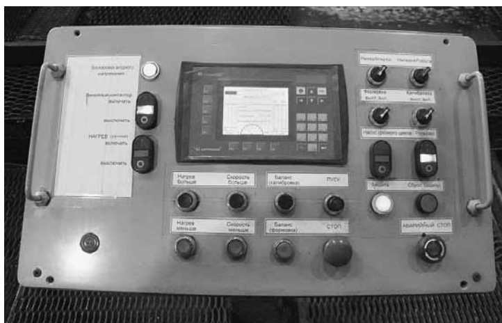
▲ Пульт управления трубопрокатным станом ТЭС 10-40
