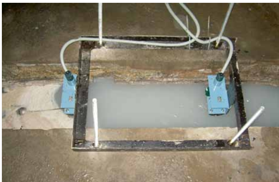
Рис. 4. РСБП «СТРИМ» в колодце
