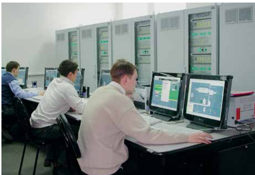
Рис. 5. Распределенная система управления турбогенераторами Сормовской ТЭЦ
