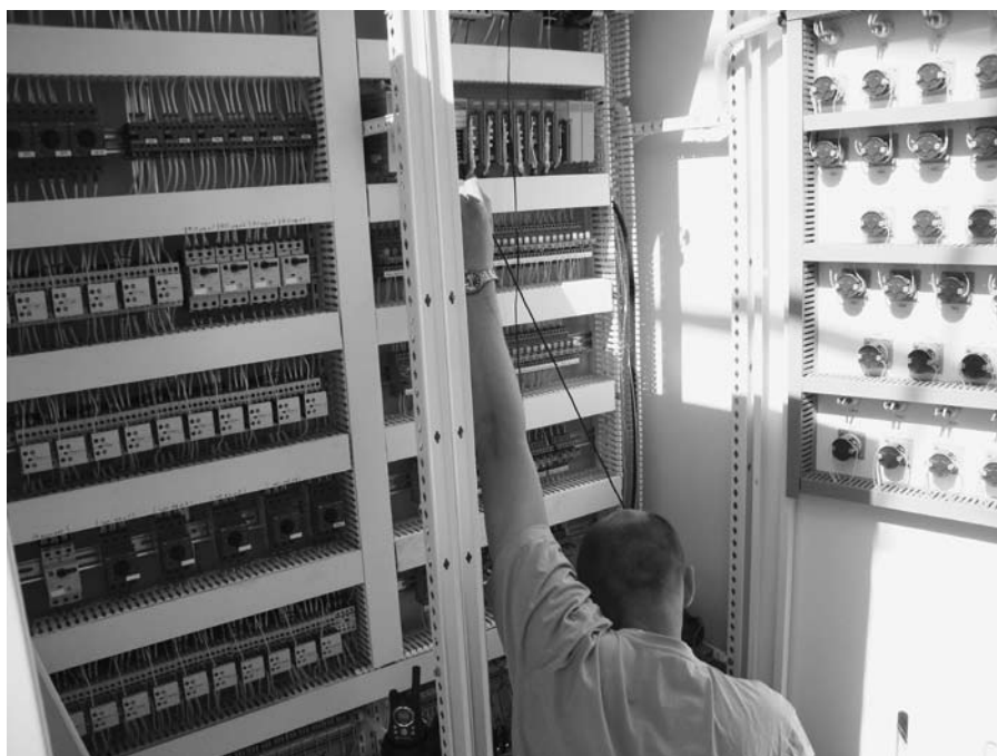
Рис. 3. Процесс пусконаладки оборудования в тепличном комплексе
